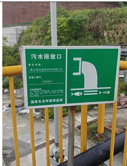
污水排放口已设标识
