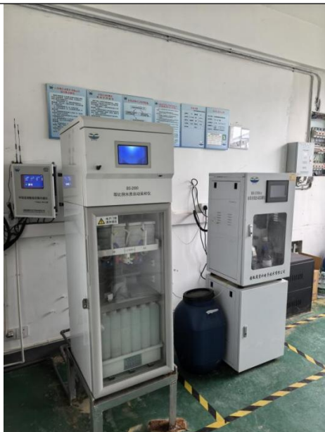
污水站安装在线监测系统
